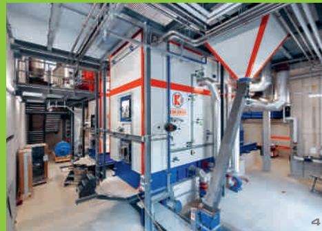
6 Die Kondensationsanlage
